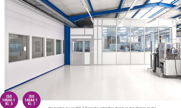
Die beiden neuen ISO 7 Bereiche schließen direkt an den Reinraum der ISO 14644-1 Klasse 5 an, der eine letzte Reinigung mit Vakuumtrocknung und eine Endmontage unserer Produkte in einer kontaminationsfreien Atmosphäre ermöglicht. Speziell geschulte Mitarbeiter nehmen die Qualitätskontrolle vor und packen für den sicheren Transport alle Reinraum-Produkte in einer zweifach verschweißten Spezialverpackung ein, die zusätzlich mit Stickstoff der Klasse 5.0 befüllt wird.
